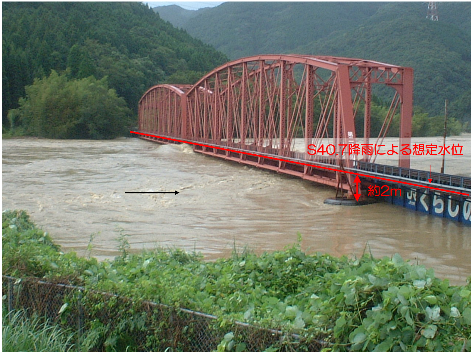
H17.9.6 16:29撮影 球磨川第二橋梁(球磨村)にS40.7降雨による想定水位を加筆
