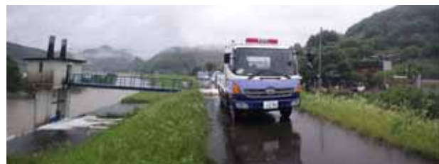
排水ポンプ車稼動状況 （2011年6月19日） （渡第二樋管）
