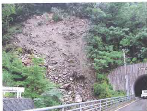
明神岩トンネル入り口の崩壊
