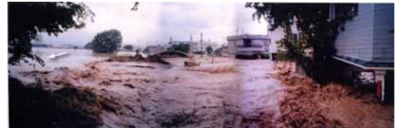
越水により堤防が決壊した事例
