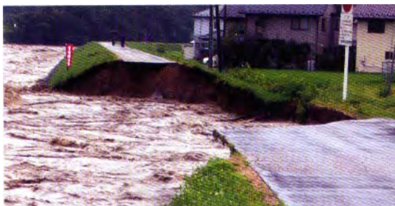
越水していなくても堤防が決壊した事例 （H18.7洪水 天竜川 洪水の状況（長野県箕輪町））
