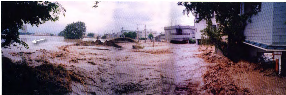
越水により堤防が決壊した事例
