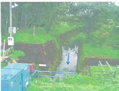
排水ポンプ場設置予定箇所
