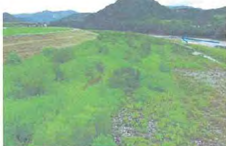
中神町左岸堤防
