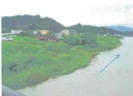
西間下町左岸（第一索道）
