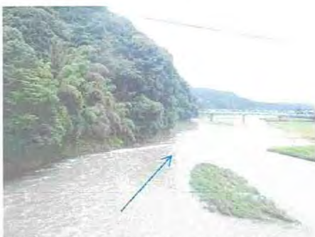
矢黒町左岸（織月大橋～西瀬橋間）
