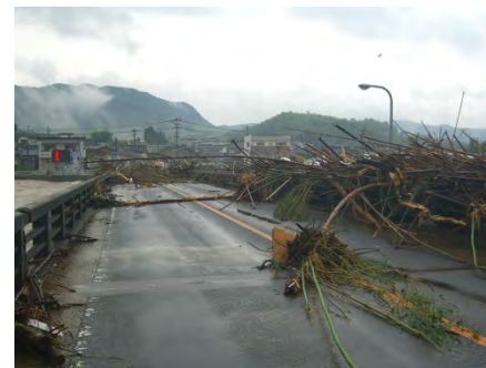
流木が橋にかかり水位を押し上げた事例 （H18.7洪水 川内川 洪水後の状況（鹿児島県さつま町））
