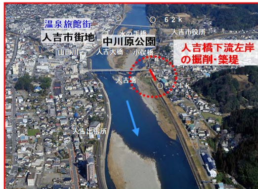
人吉橋下流左岸の掘削・築堤
