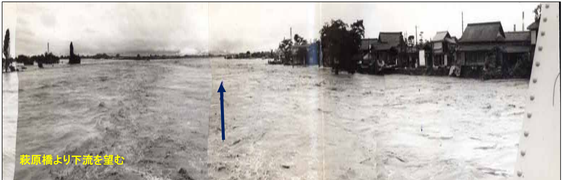
八代市萩原付近の出水状況
