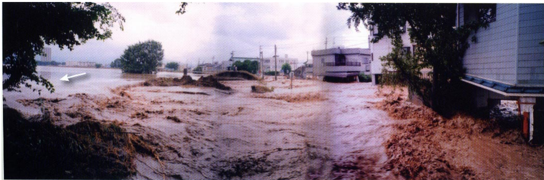
越水により堤防が決壊した事例 あすわ (H16.7洪水 足羽川 洪水の状況(福井県福井市))
