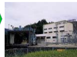
⑤市房第二発電所
