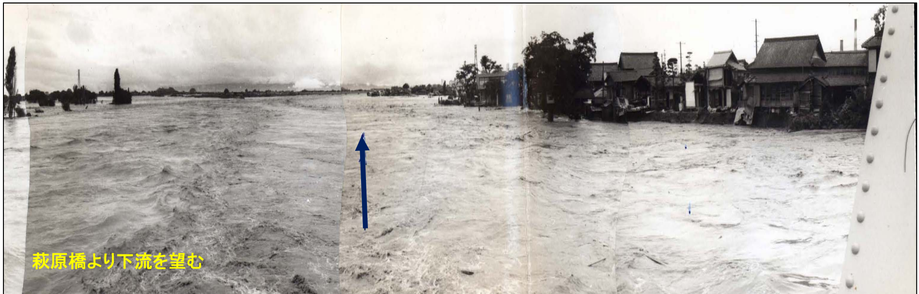
八代市萩原付近の出水状況
