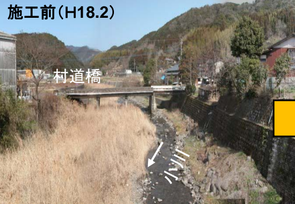
①村道橋嵩上げおよび②築堤 施工前・後 写真 (※下流から上流を望む)
