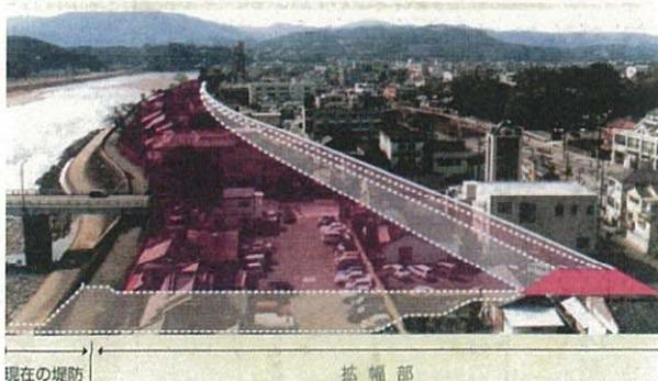
国交省資料「球磨川水系の治水について」(平成13年10月)の引提案。毎秒7000 $\text{m}^3$ の洪水を目標にしている
