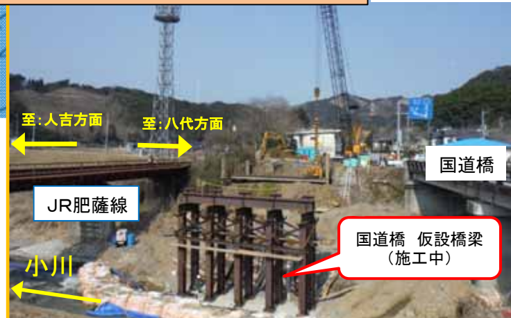
④国道橋 仮設橋梁工事 施工写真
