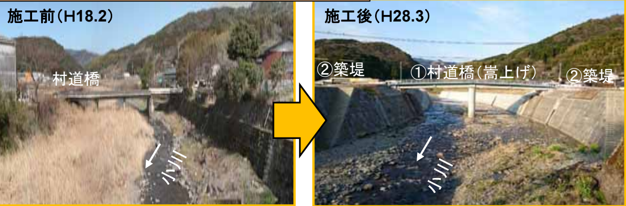
①村道橋嵩上げおよび②築堤 施工前・後 写真 (下流から上流を望む)
