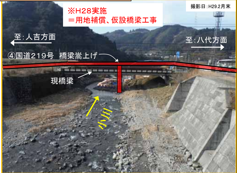
④国道橋嵩上げ イメージ写真 (上流から下流を望む)
