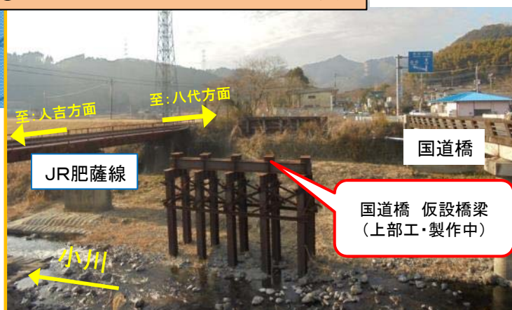
④国道橋 仮設橋梁工事 状況写真
