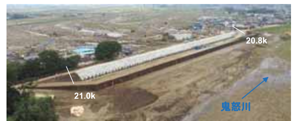
応急復旧状況(9/24)
