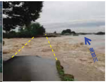
被災状況(拡大写真)
