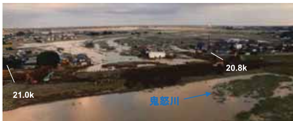
応急復旧状況(9/12)
