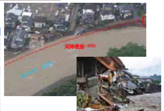
河岸侵食に伴う家屋倒壊
