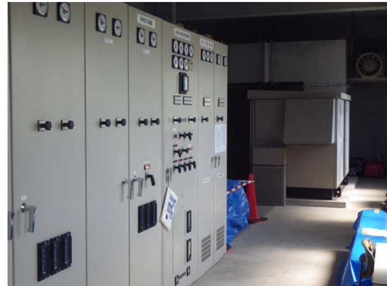
非常用電源設備を設置
