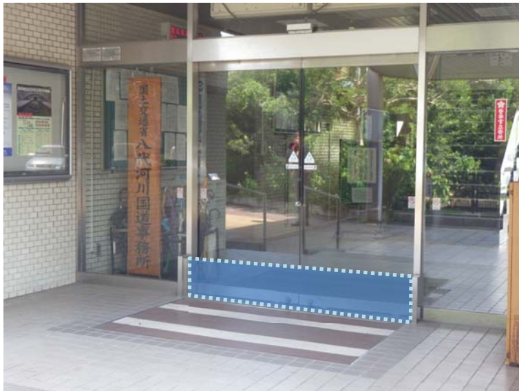
浸水時は止水板を設置
