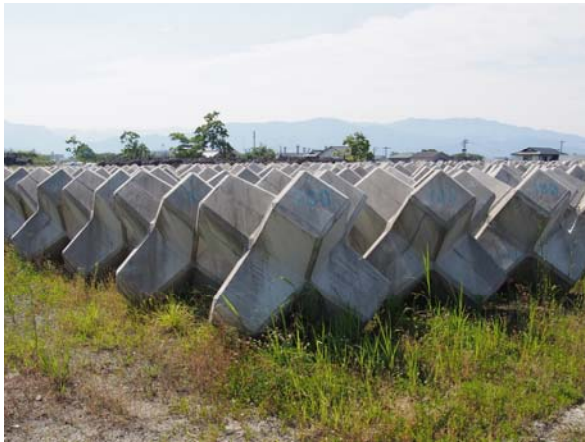
資機材の備蓄状況
