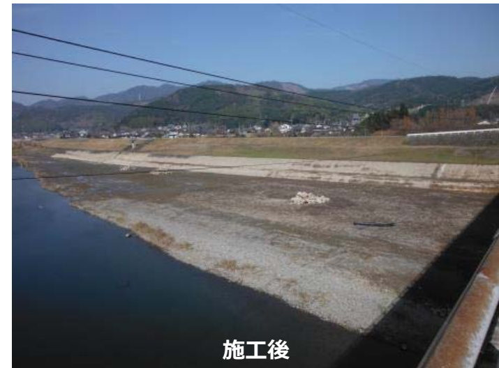
流下能力を確保するための河道掘削
