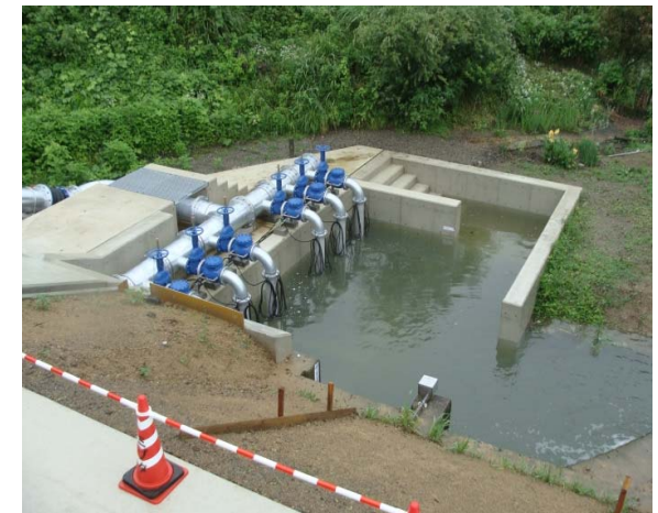
川裏側（釜場、ポンプ）の状況
