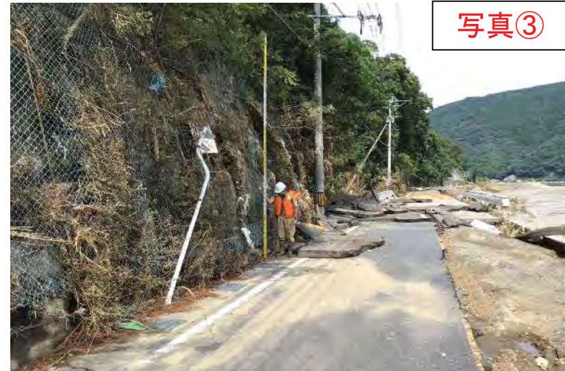
洪水流により被災した国道219号
