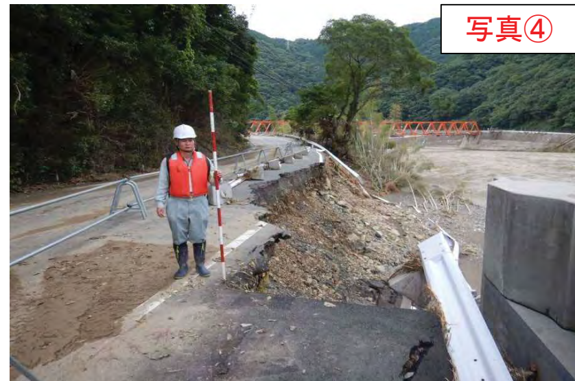
洪水流により被災した国道219号
