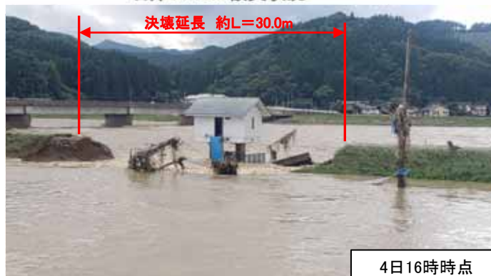
右岸56k400被災状況
