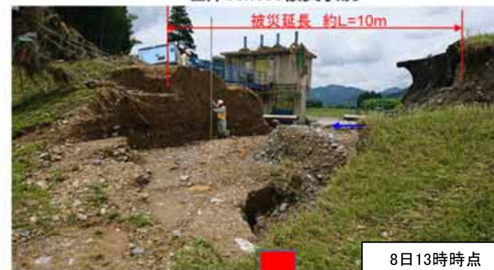
左岸55k000被災状況
