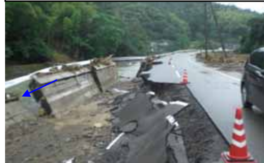
吉尾川・護岸一部欠損
