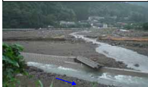
吉尾川・護岸一部欠損
