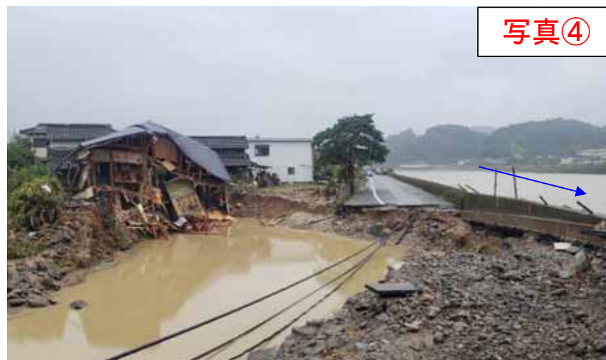
堤防の損傷と氾濫流による家屋倒壊が発生 (人吉市下薩摩瀬町)
