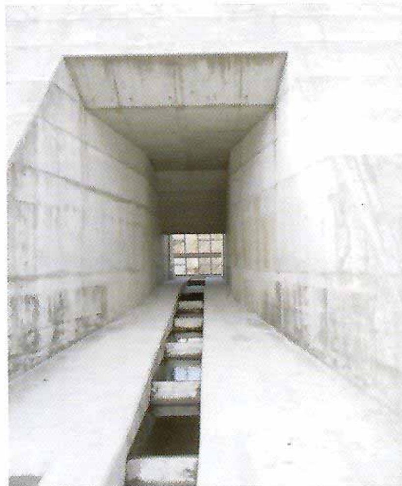
常用洪水吐きとその中に設置された魚道 (西之谷ダム)
