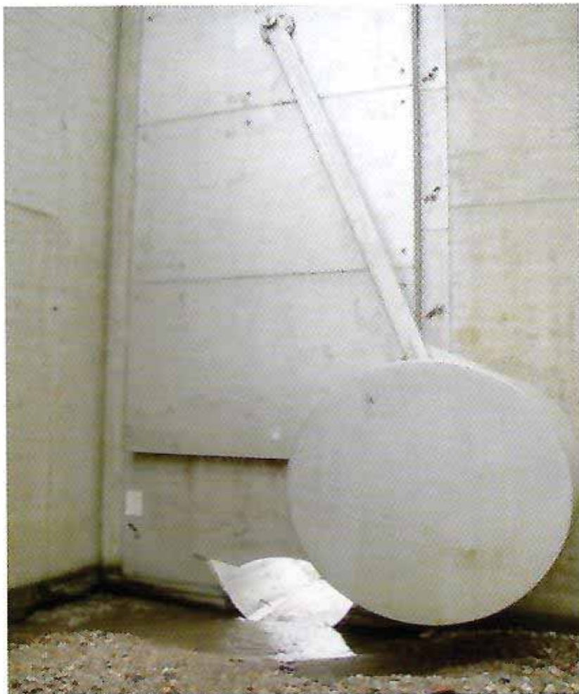
フロートによる開度の自動調整機能を有する 常用洪水吐き (オーストリア)
