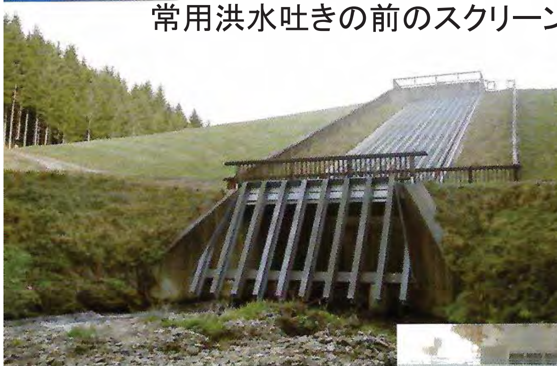
特徴のある常用洪水吐きのスクリーン (オーストリア)
