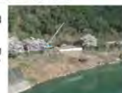
国道219号の復旧状況(八代市坂本町)
