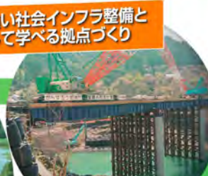
仮設設置が進む球磨川(八代市坂本町)
