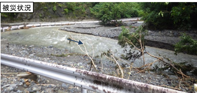
堆積土砂撤去(免田川・あさぎり町)
