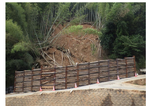
急傾斜施設応急対策(上村・芦北町)
