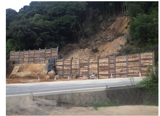
急傾斜施設応急対策(上村・芦北町)
