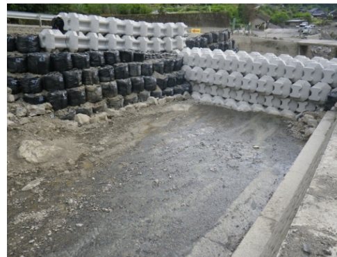
砂防堰堤応急対策(川内川・球磨村)
