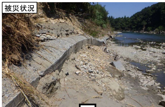
災害復旧工事着手(川辺川・相良村)
