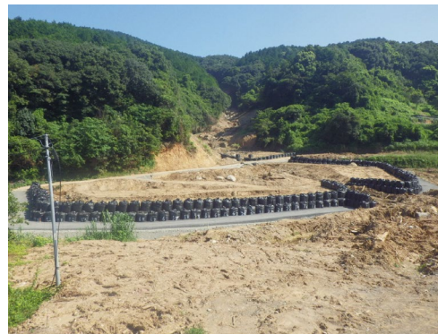
砂防堰堤応急対策(川内川・球磨村)
