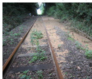
軌道内土砂流入
