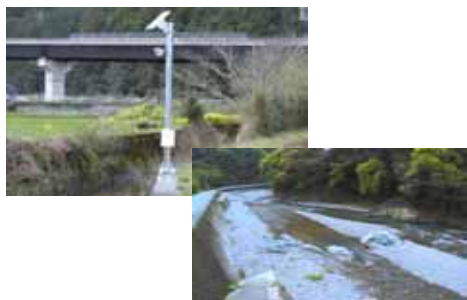
河川監視カメラの設置状況
