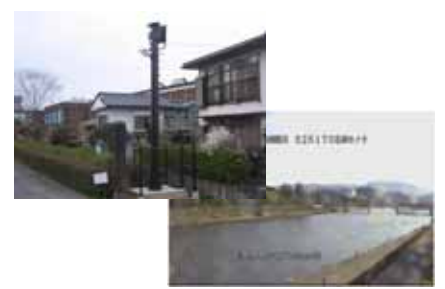
河川監視カメラの設置状況
