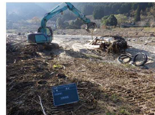
ダム湛水区間における堆積土砂・流木・ゴミの除去（市房ダム）
