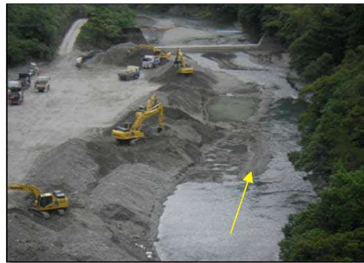
ダム湛水区間における堆積土砂・流木・ゴミの除去（市房ダム）
