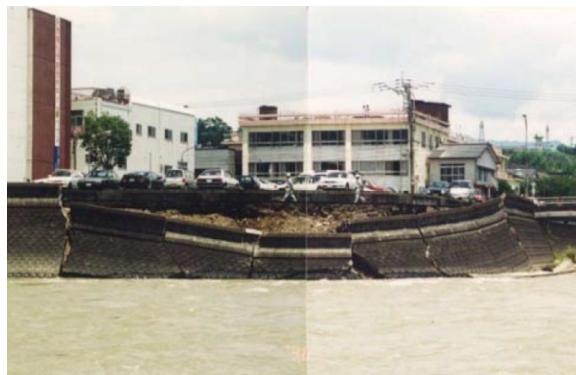
図 2.19 基礎洗掘により崩壊した護岸
