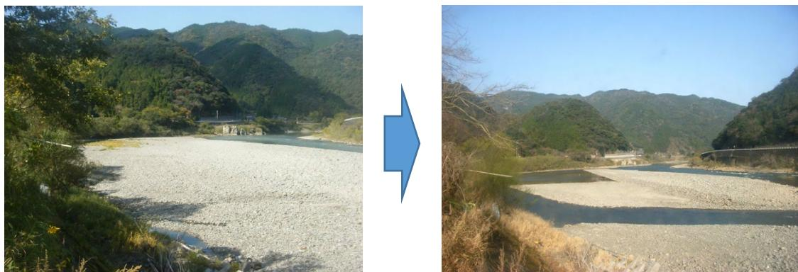
図 1.58 八代市坂本町の堆積土砂の掘削
