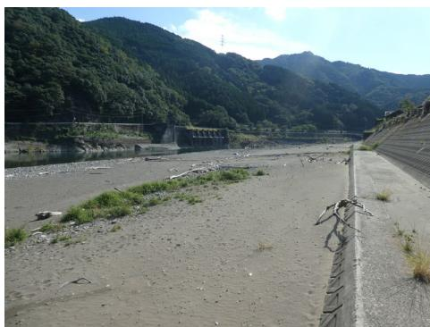
図 2.16 河道内の土砂堆積状況
