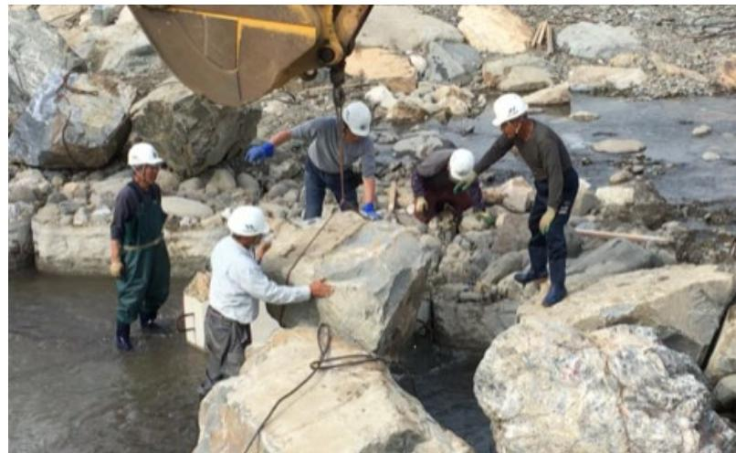
図 6.11 石工の巨石設置の技術（八の字堰の施工状況）
