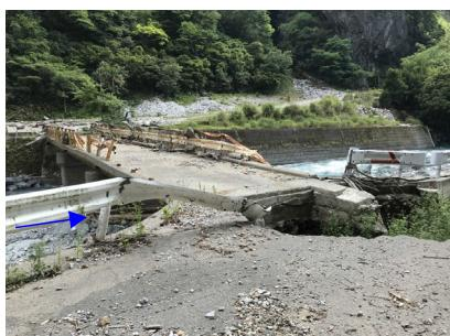
写真 2.2 令和2年7月豪雨における梶原川の土砂・流木による橋梁の被害状況
