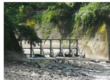
写真 5.2 流木止工施設の例
