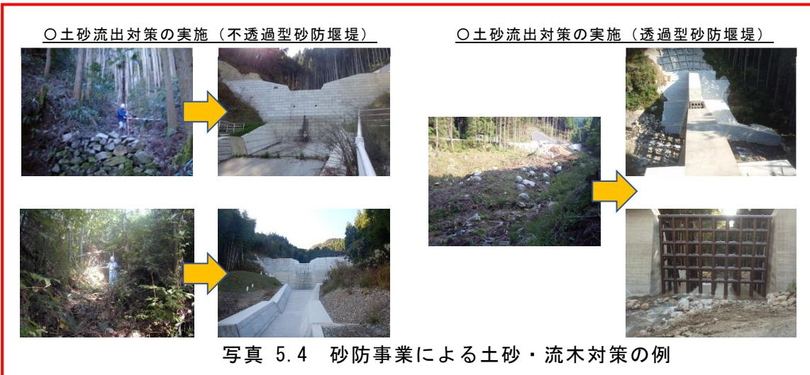
写真 5.4 砂防事業による土砂・流木対策の例
