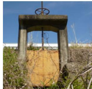
写真 2.7 老朽化した樋管
