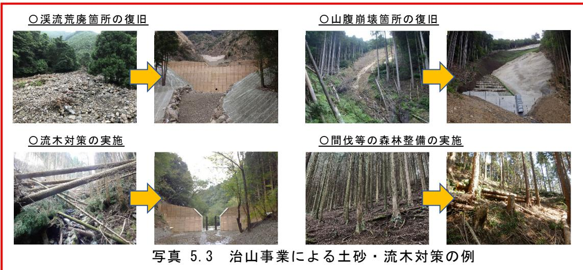
写真 5.3 治山事業による土砂・流木対策の例
