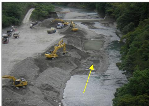
写真 5.14 ダム湛水区間における堆砂土砂の掘削や流木・ゴミの除去（市房ダム）
