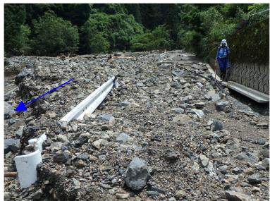
写真 2.1 令和2年7月豪雨における川内川の堆積土砂による被害状況
