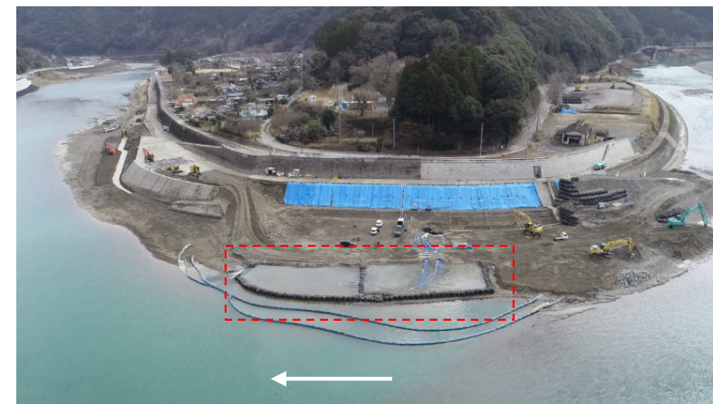
沈砂池設置状況
