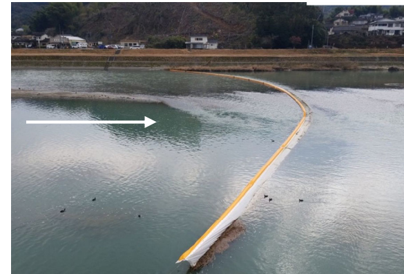
汚濁防止フェンスの設置状況
