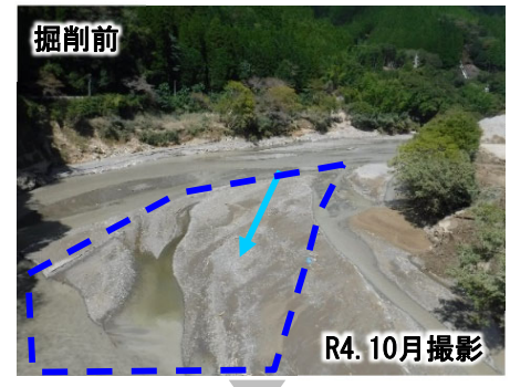
④ 市房ダム
