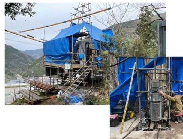
地質調査の状況
