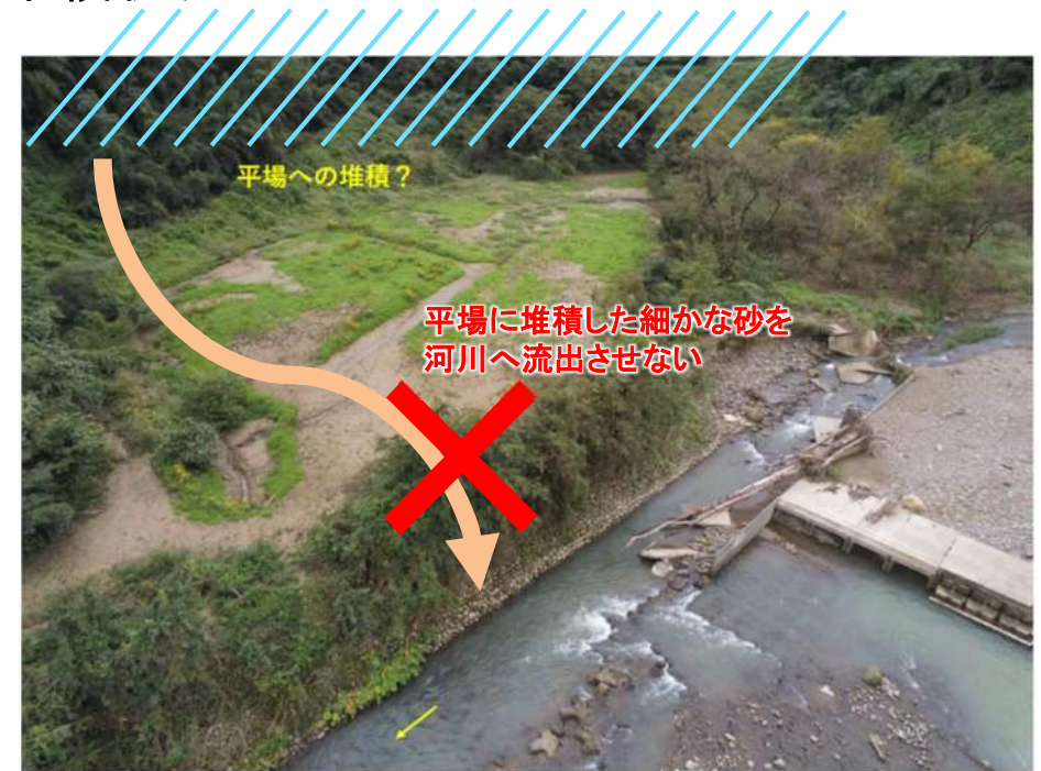
既往流水型ダム（辰巳ダム）の 洪水調節後の堆積状況
