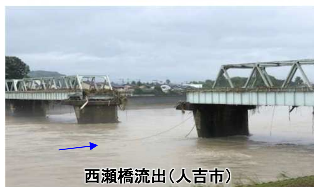
球磨川鉄道 橋梁流出 (くま川鉄道Webサイトより)
