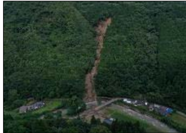
緊急に復旧すべき山腹崩壊箇所
