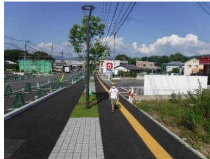
施工事例 県道熊本高森線（益城町）
