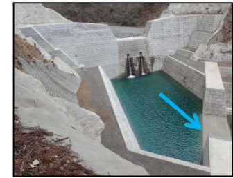
②久連子川第8砂防堰堤(H29.3)
