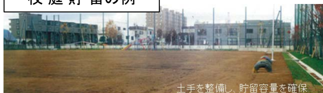
土手を整備し、貯留容量を確保
