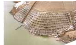
貯水池法面の保護
