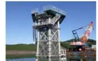
取水設備の整備
