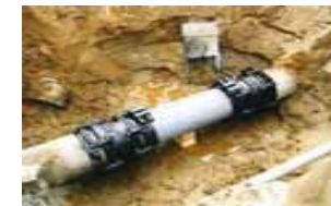
漏水防止のための整備
