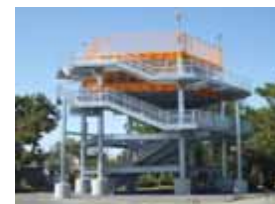
津波避難タワー
