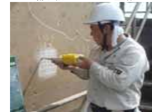
老朽化した施設の機能診断
