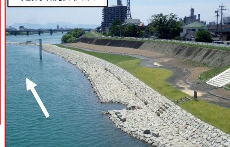
深掘れ箇所の対策完了 (R2. 6)
