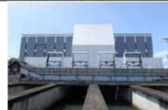
中央雨水ポンプ場 (八代市)
