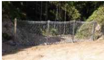
柔構造バリアにより流木や土石等を捕捉する
