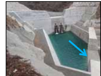
②久連子川第8砂防堰堤 (H29.3)
