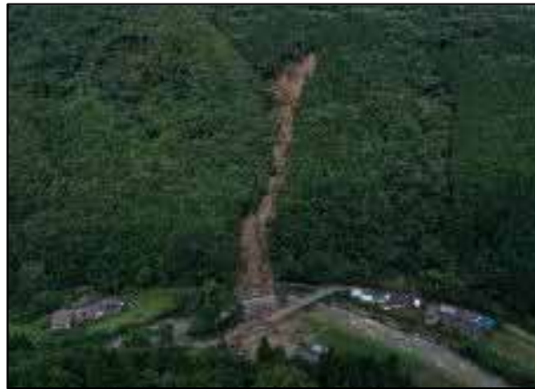
緊急に復旧すべき山腹崩壊箇所
