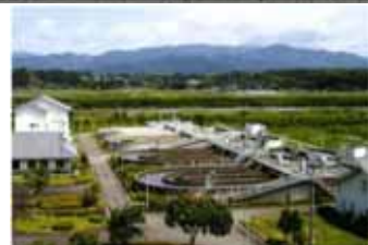
球磨川上流浄化センター (熊本県)
