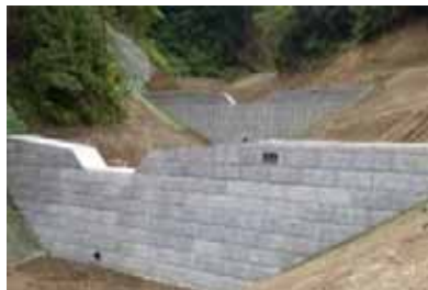
谷止工により溪床の安定を図る
