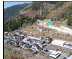
③高野川第2砂防堰堤
