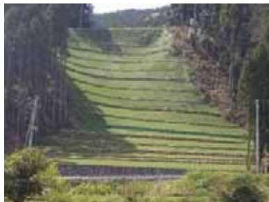
山腹工により崩壊斜面の安定を図る
