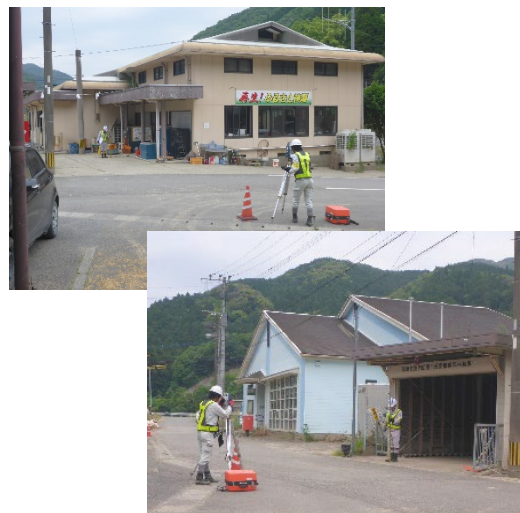
輪中堤・宅地かさ上げの設計・検討に向けた家屋敷高の測量状況 [球磨村]
