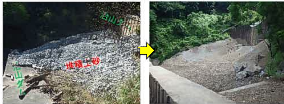
県による治山ダム上部の土砂撤去（五木村 土会平地区）
