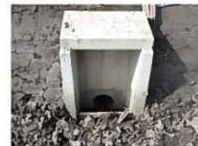
落水口の整備
