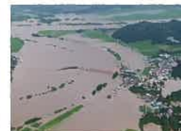
本川からの浸水状況
