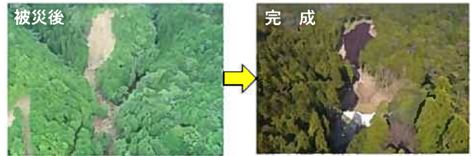
国有林内の工事完成箇所（湯前町 七ツ山地区）
