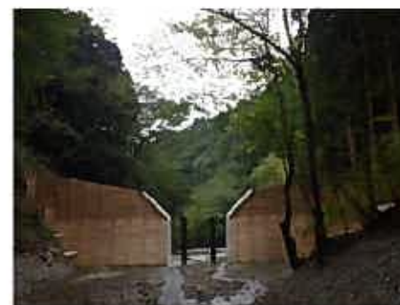
流木捕捉式治山ダム
