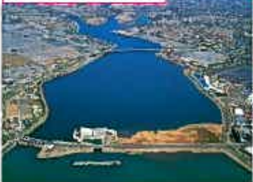
排水機場と周辺の市街地
