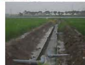
「田んぼダム」実施
