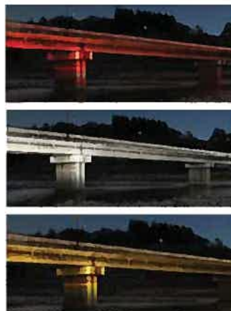
ライティング防災アラートシステム (人吉市)
