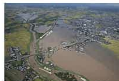
合流部での浸水状況
