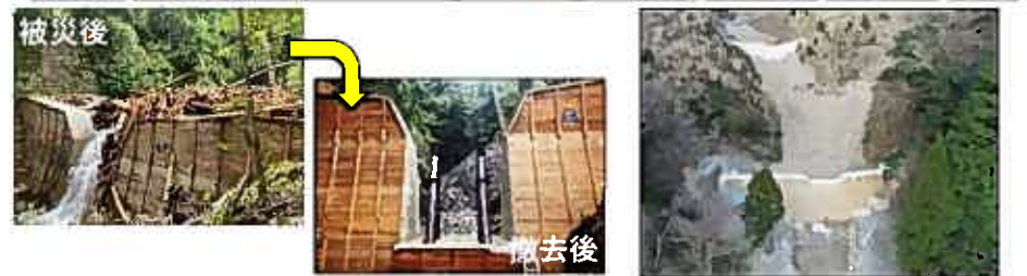
土砂・流木を撤去した治山ダム 土石流発生源での治山ダム整備
