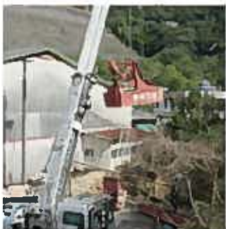
球磨川第一橋梁(八代市)
