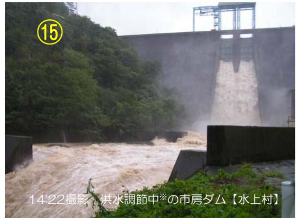
※ 6日8:30に、最大流入量941ト/sのうち約425ト/sをダムに貯留し、下流の被害を軽減した。
