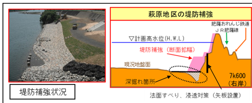
図 八代市萩原地区の堤防補強
