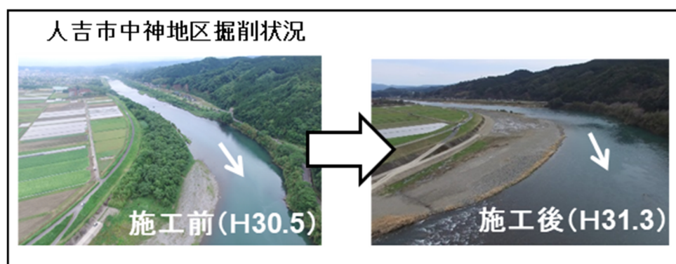
図 人吉市中神地区掘削状況
