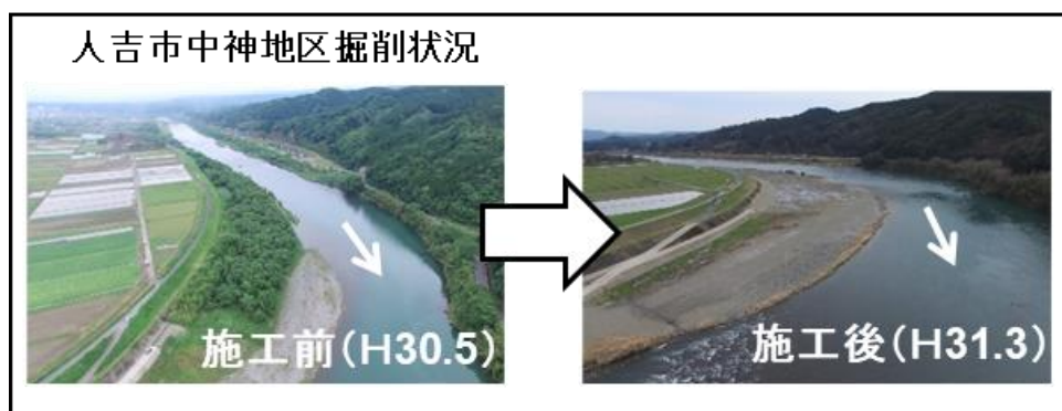
図 人吉市中神地区掘削状況
