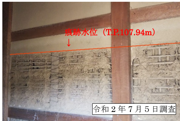
写真 球磨川左岸 61/400、61/600 洪水痕跡水位計測位置
