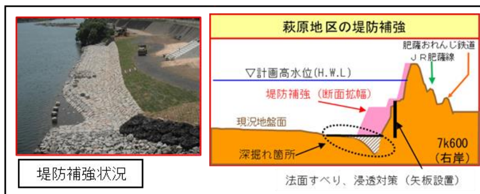
図 八代市萩原地区の堤防補強
