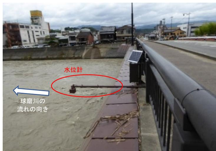
写真1 危機管理型水位計の設置写真
