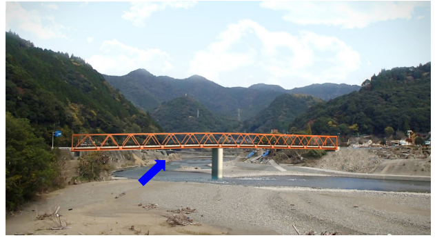
坂本橋【鋼2径間連続トラス橋】
