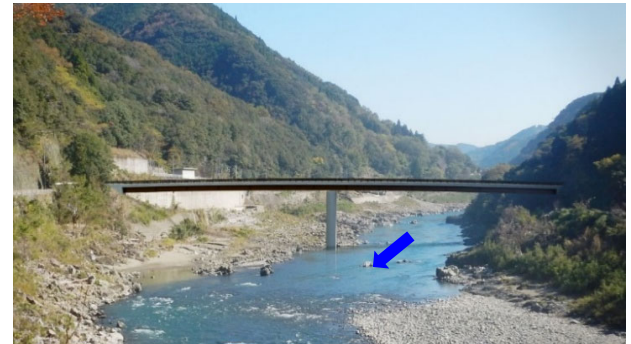
松本橋【鋼2径間連続鋼床版箱桁橋】
