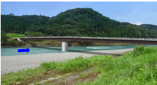
沖鶴橋【鋼2径間連続鋼床版箱桁橋】
