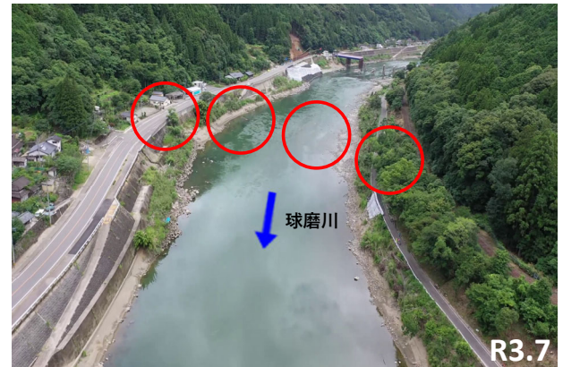
【復旧位置写真（神瀬橋）】
