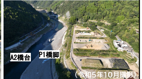
大瀬橋の工事状況
