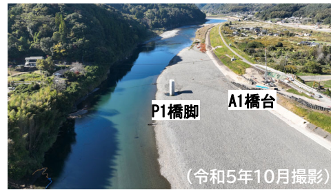
沖鶴橋の工事状況
