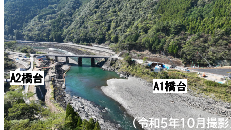
鎌瀬橋の工事状況
