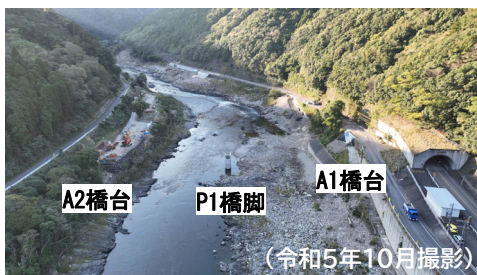
松本橋の工事状況
