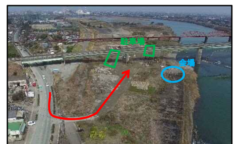
③左折後場内駐車場まで進入 工事の資機材があるので注意
