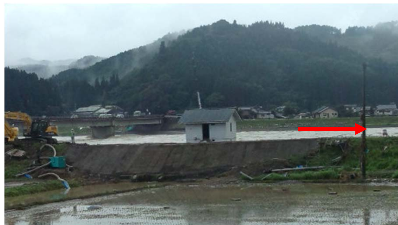
2020.07.06 9時00分頃 仮堤防概成
