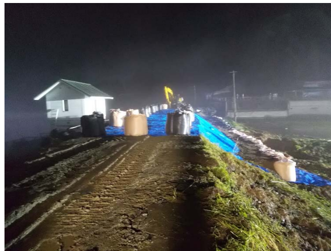
2020.07.06 24時00分頃 復旧完了
