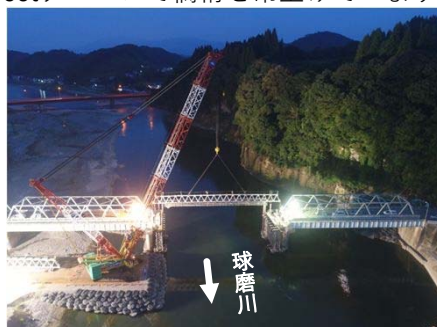
(500tクレーンで橋桁を吊上げています)
