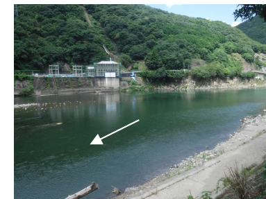
上流側の状況 (R3.8撮影)
