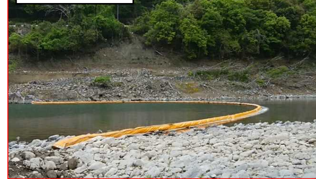
汚濁防止フェンス
