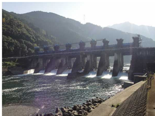
荒瀬ダム（平成30年3月撤去）
