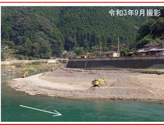
河道掘削状況及び掘削断面 (球磨川右岸25k0付近)
