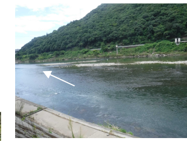
下流側の状況 (R3.8撮影)
