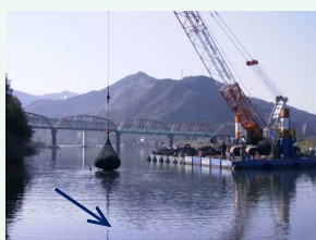
萩原地区の深掘対策状況(八代市)
