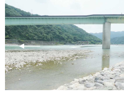
左岸土砂堆積状況 (R2.8撮影)
