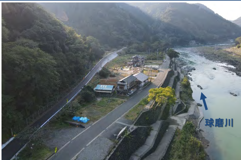
施工状況(令和7年1月末時点)
