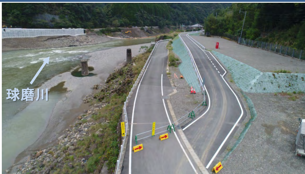
施工状況（令和7年1月末時点）
