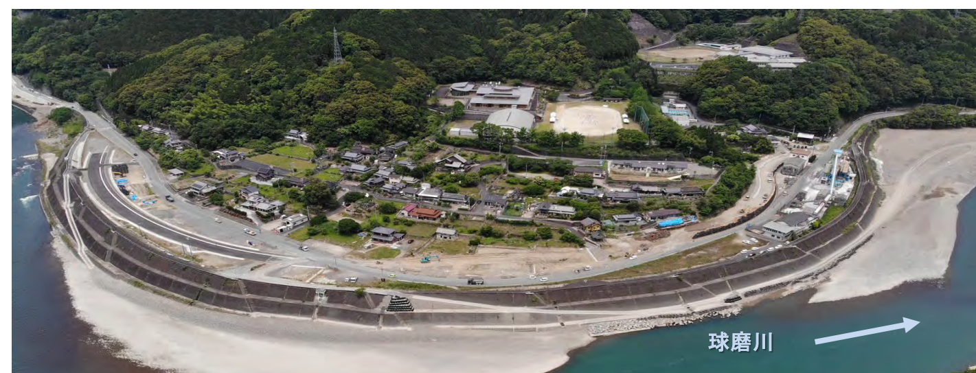
施工状況（令和6年5月末時点）
