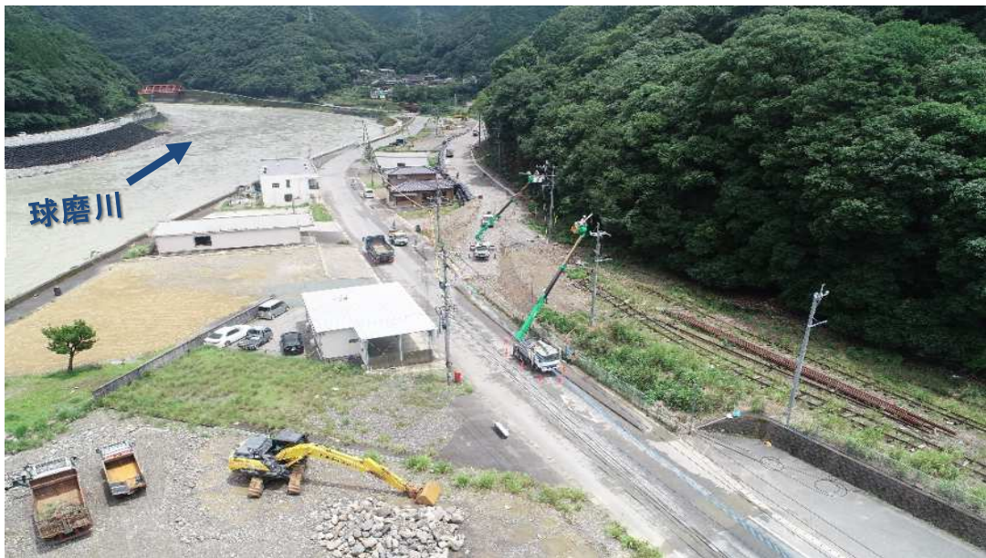
施工状況（令和6年9月末時点）
