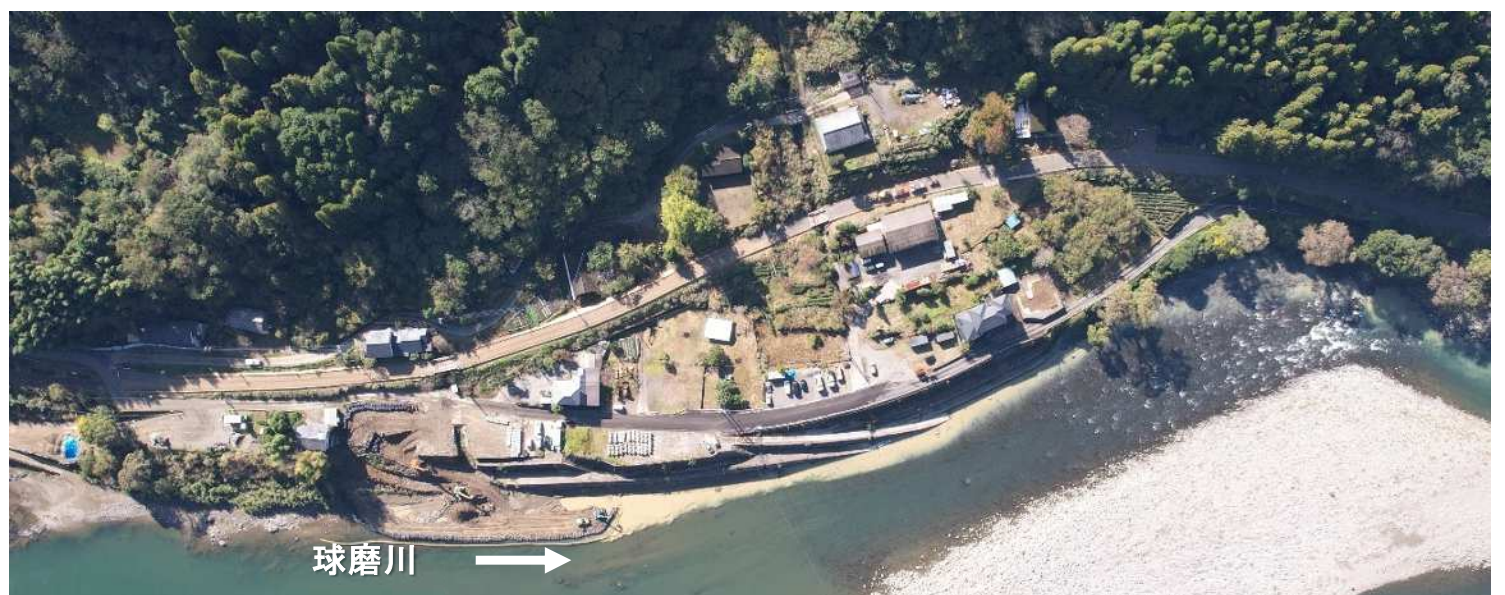
施工状況(令和7年11月末時点)
