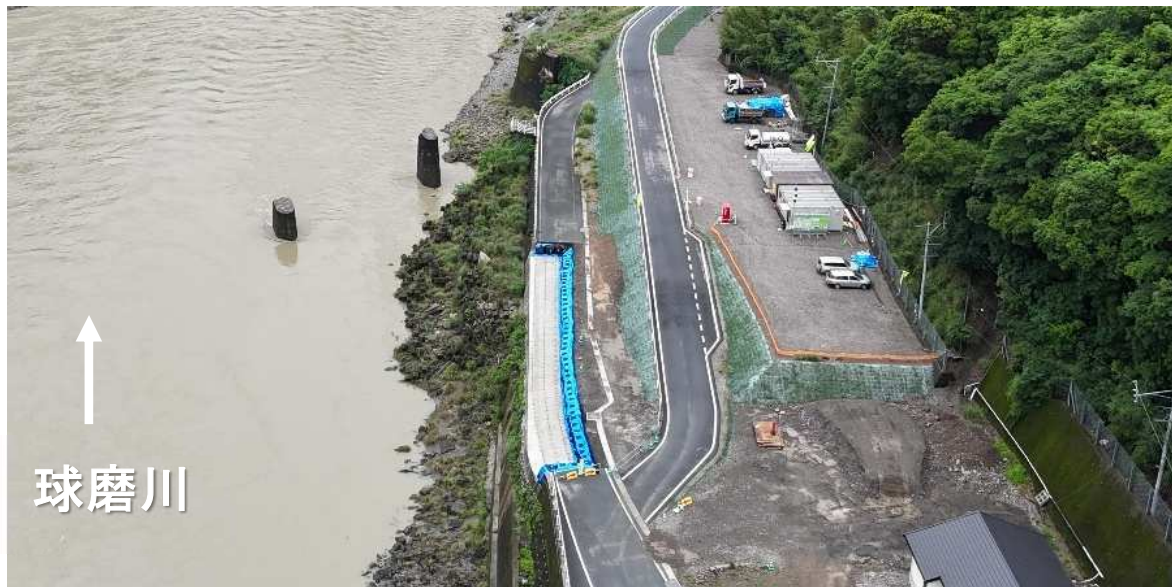
施工状況（令和7年7月末時点）
