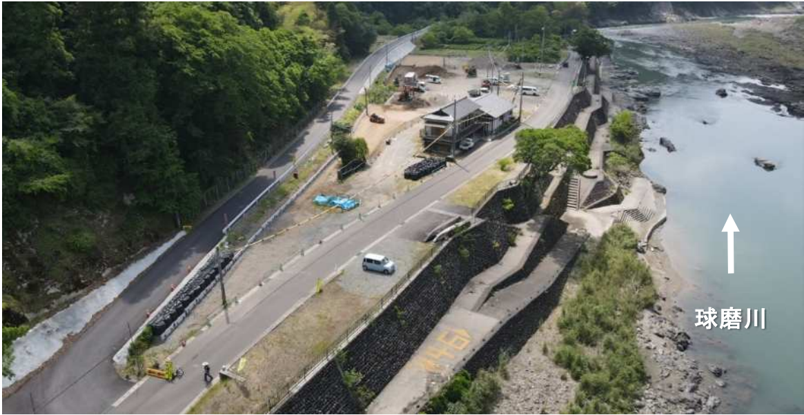
施工状況（令和7年7月末時点）
