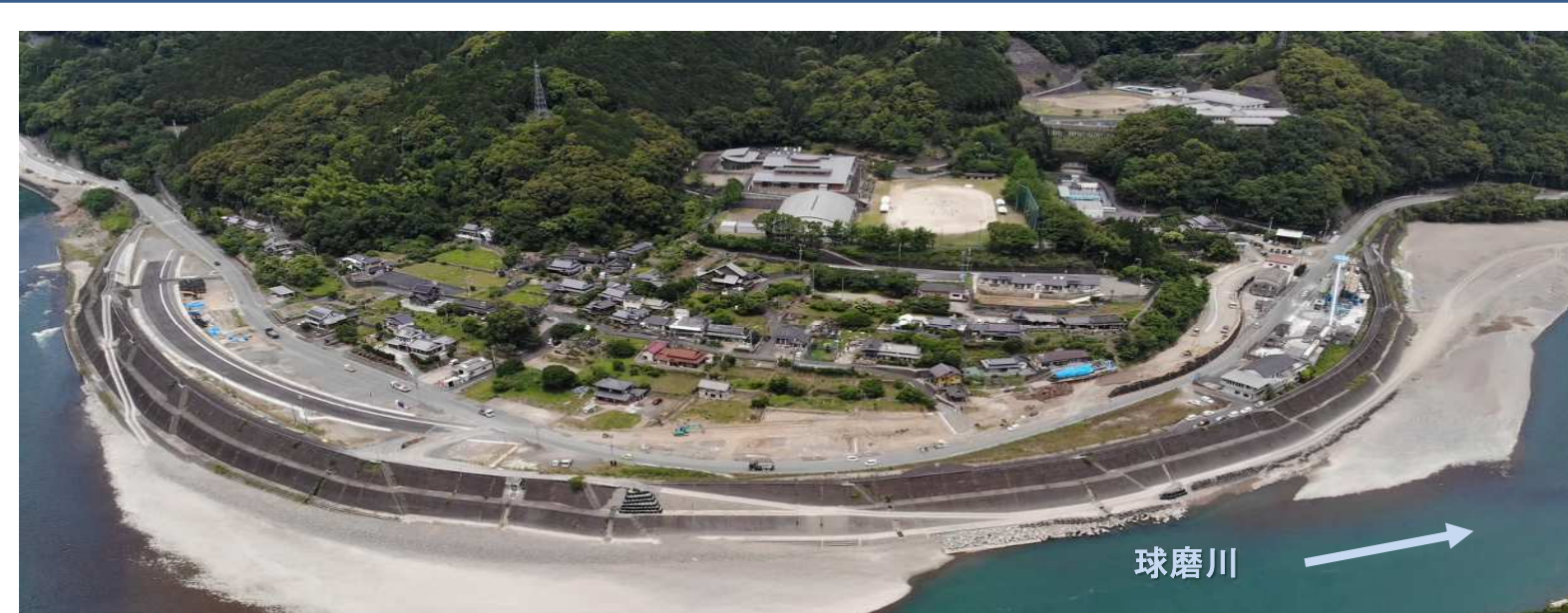
施工状況（令和6年5月末時点）
