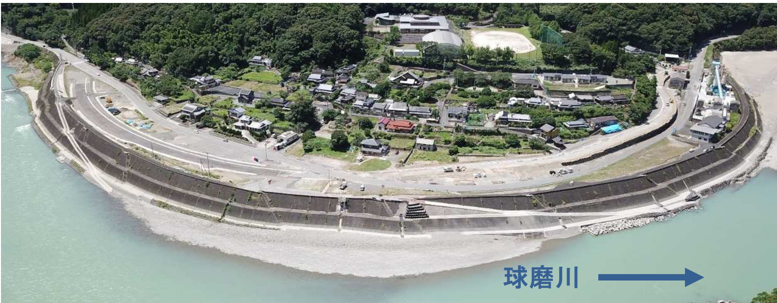
施工状況（令和6年9月末時点）
