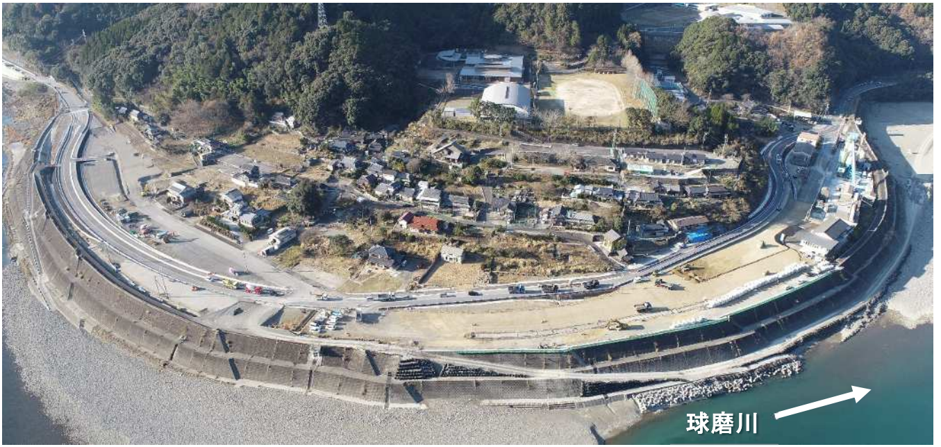
施工状況（令和7年3月末時点）
