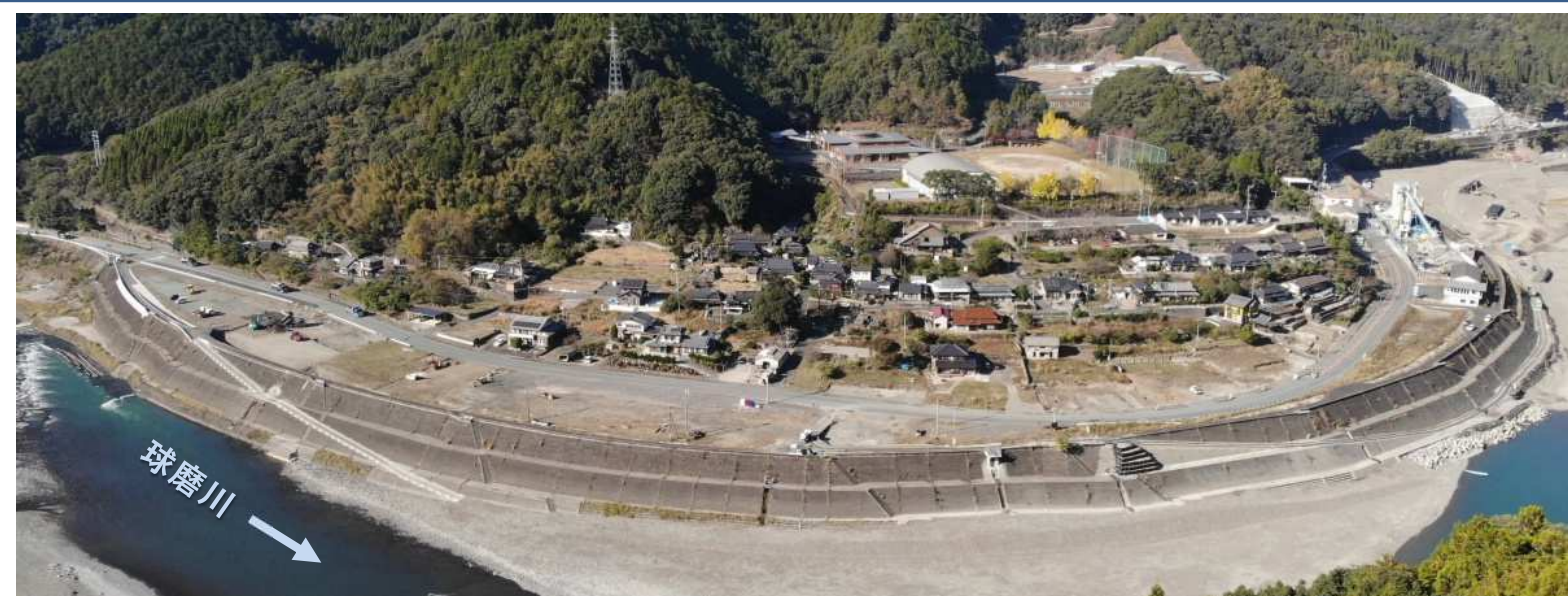
施工状況（令和5年12月末時点）
