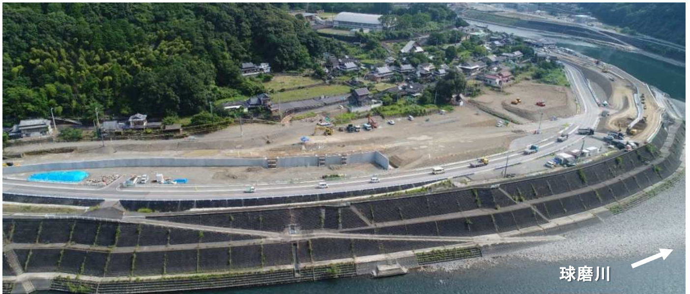
施工状況（令和7年9月末時点）
