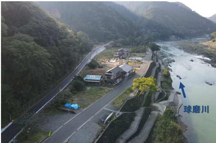
施工状況(令和7年1月末時点)
