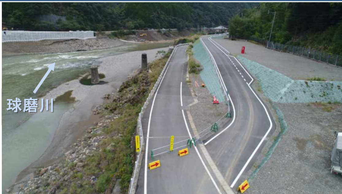
施工状況（令和7年1月末時点）
