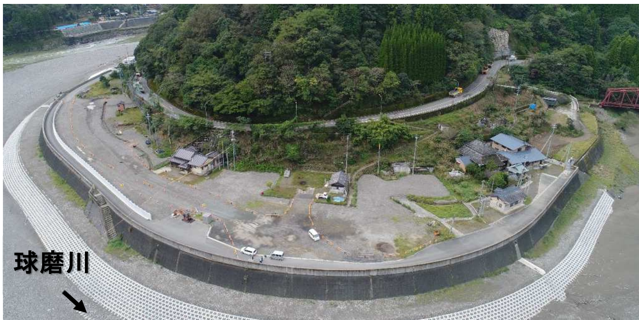
施工状況（令和7年3月末時点）
