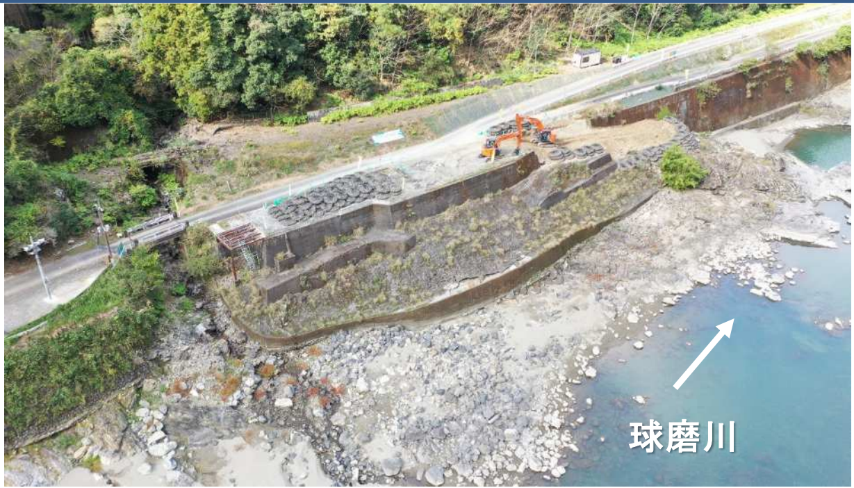
施工状況（令和7年11月末時点）
