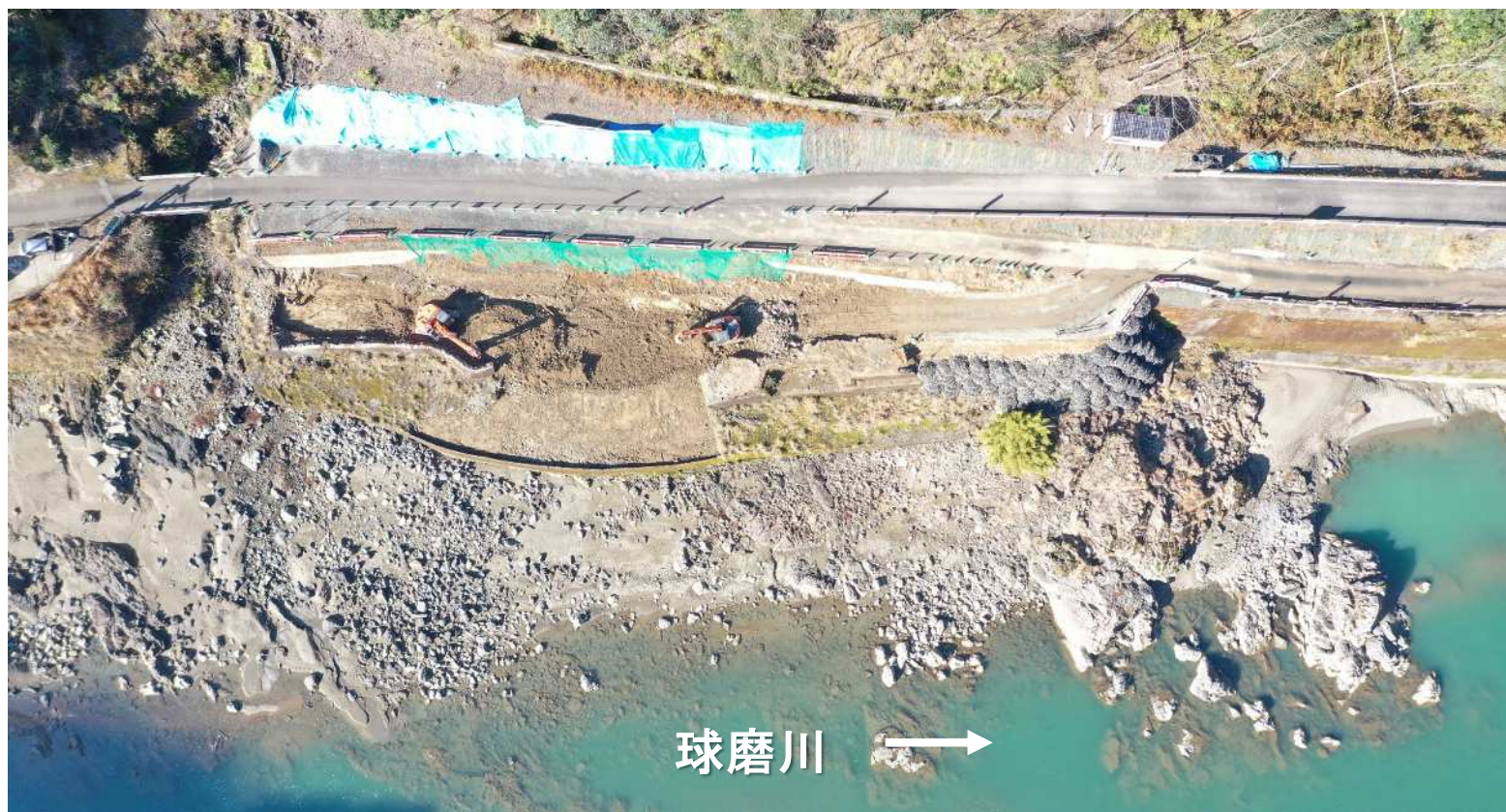
施工状況（令和8年1月末時点）
