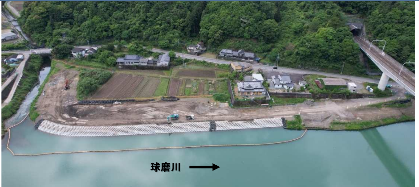
施工状況（令和7年7月末時点）
