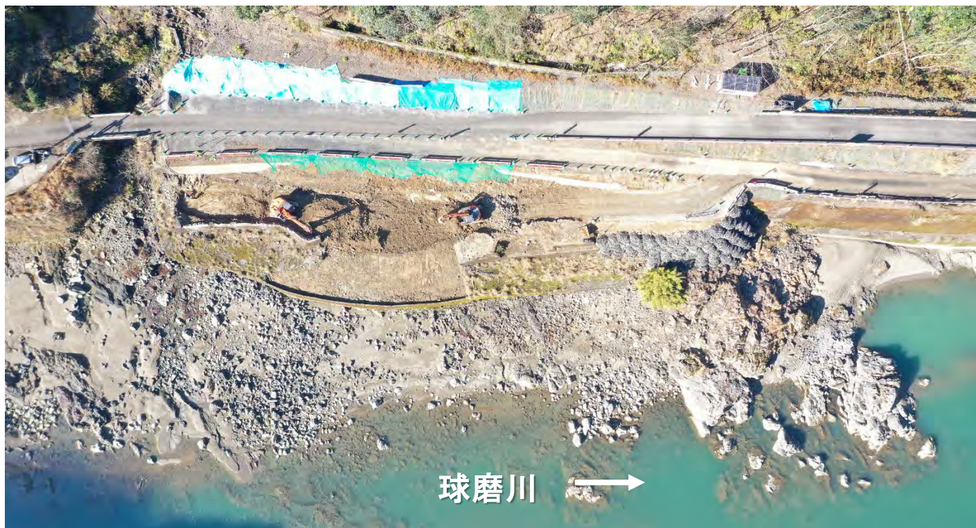
施工状況（令和8年1月末時点）
