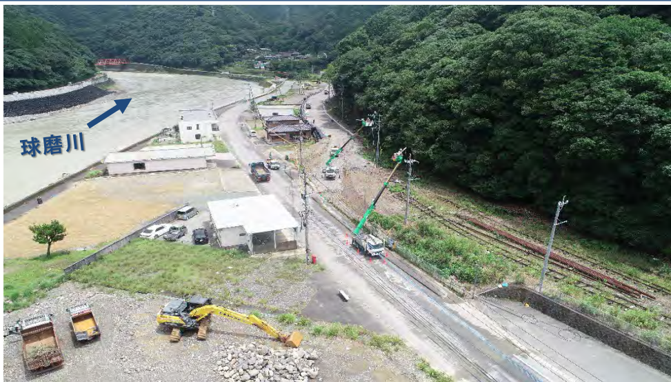
施工状況（令和6年9月末時点）
