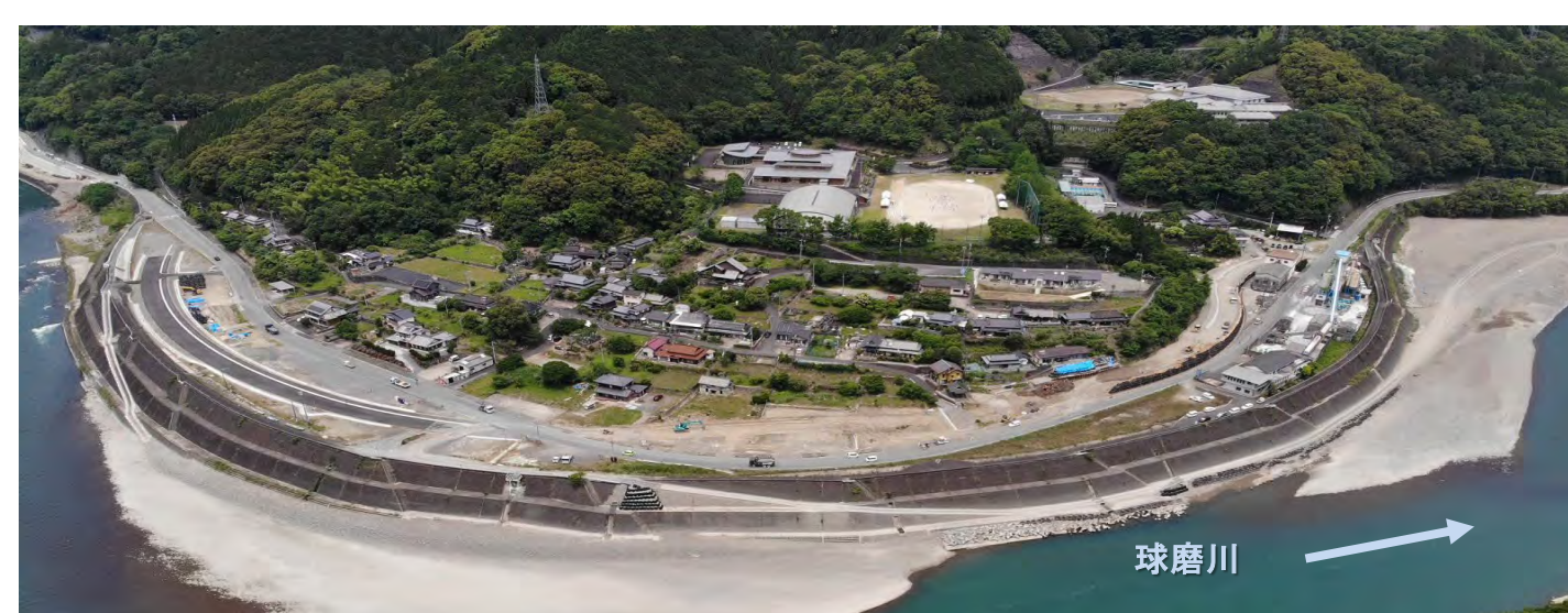
施工状況（令和6年5月末時点）
