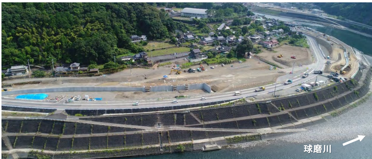
施工状況（令和7年9月末時点）
