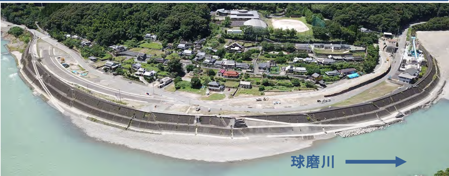
施工状況（令和6年9月末時点）
