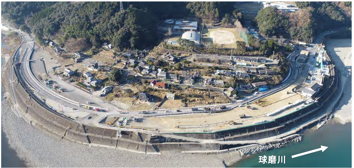
施工状況（令和7年3月末時点）
