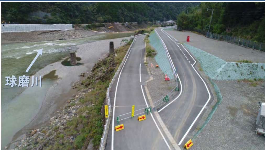
施工状況（令和7年1月末時点）
