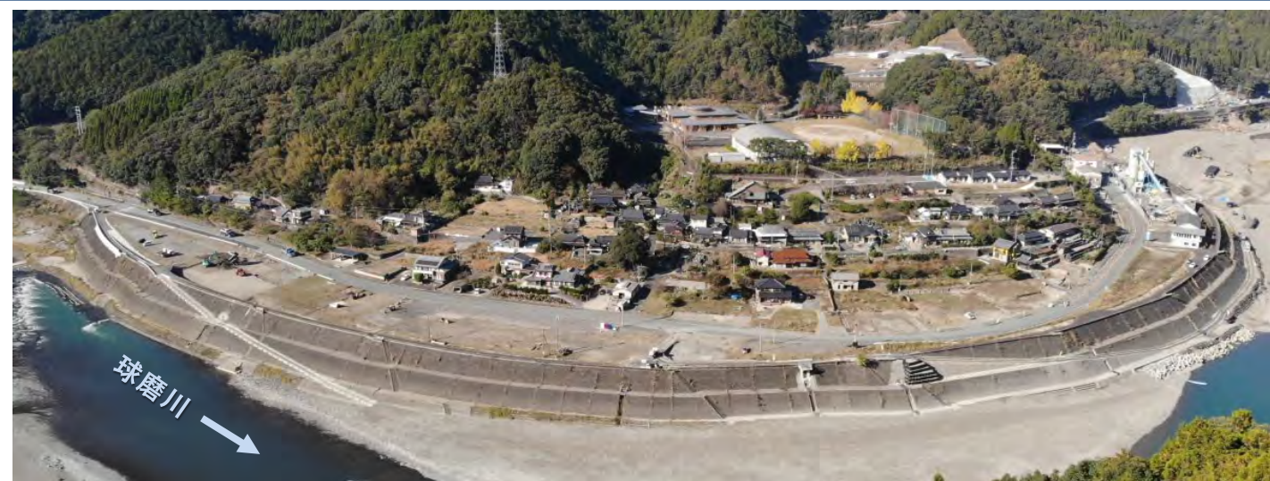
施工状況（令和5年12月末時点）
