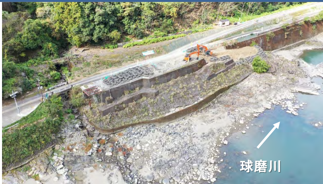
施工状況（令和7年11月末時点）
