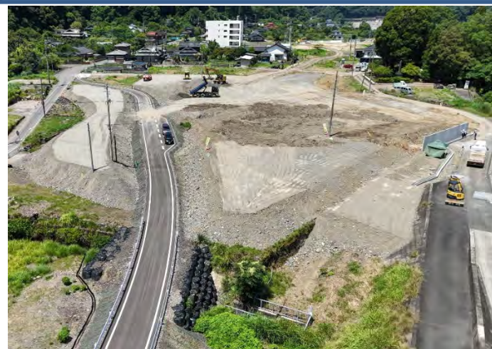
施工状況（令和7年7月末時点）
