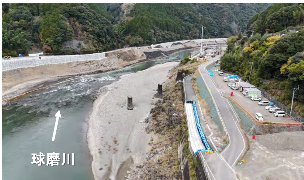
施工状況（令和8年1月末時点）
