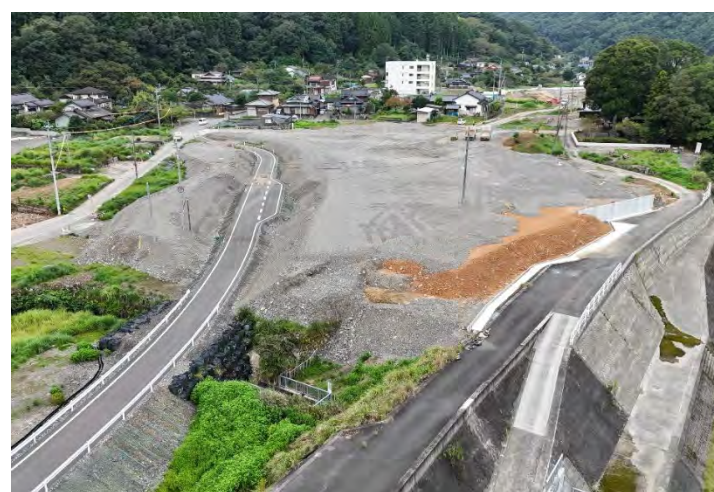
施工状況（令和7年9月末時点）
