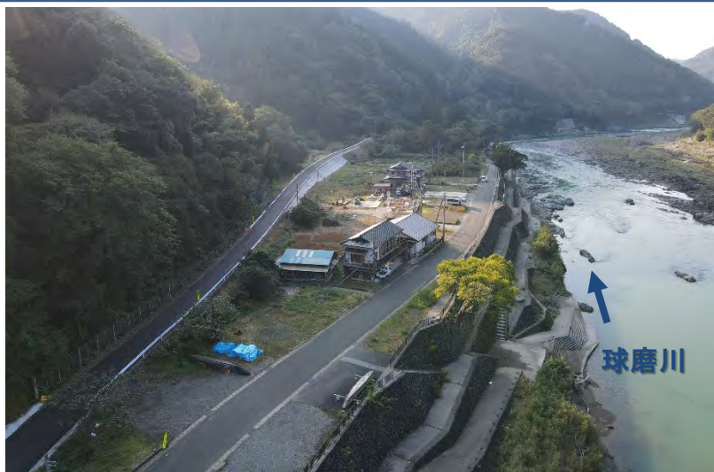
施工状況(令和7年1月末時点)
