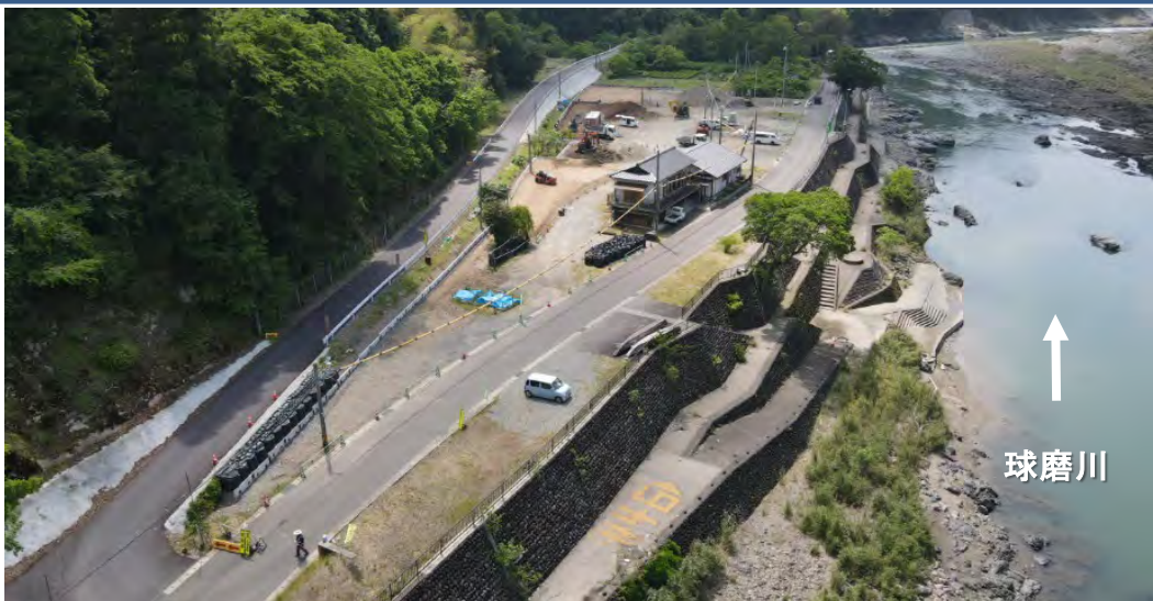
施工状況(令和7年7月末時点)
