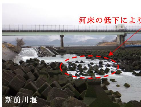
河床の低下により段差が生じている。
