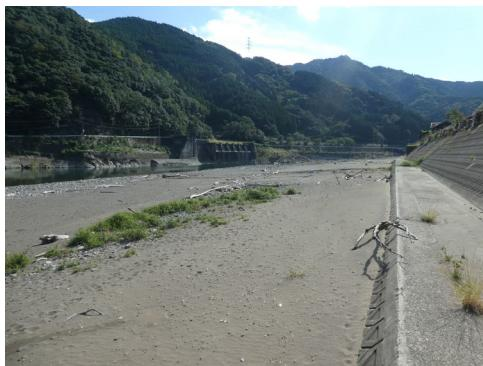
図 2.16 河道内の土砂堆積状況
